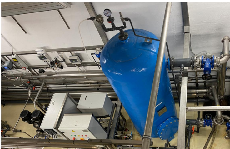
Slika 1. Pogled na sustav za ozonizaciju (generator, rashladni sistem, upravljački ormar, reakciona posuda, analizator ozona u vodi i detektor ozona u vazduhu) na prezentovanom praktičnom primeru „R“ Figure 1. View of ozonation system (ozone generator, cooling system, power supply and control panel, reactor, dissolved ozone analyser, ozone in air detector) „R“
