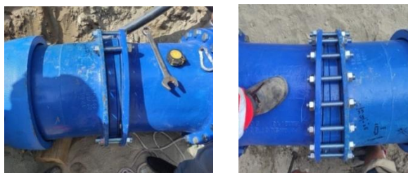
Слика 5. Приказ уградње Подесивог прирубничког прстена - PPP, DN500
