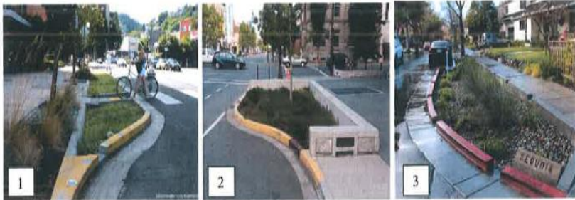
Slika 1. Bioretenzije kao produžetak ivičnjaka
