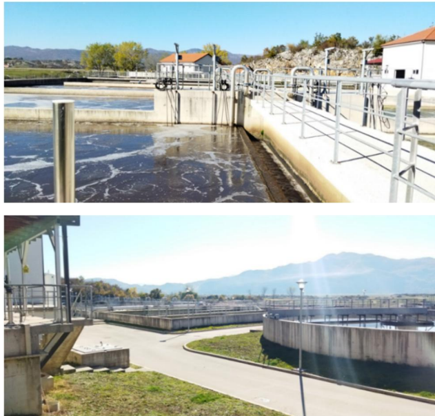
Slika 1. Postrojenje za prečišćavanje otpadnih voda u Nikšiću
