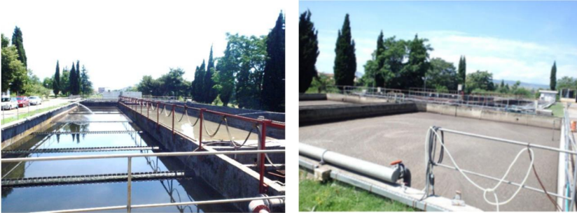
Slika 4. Prečišćivač, primarni taložnik i bazen za aeraciju Figure 4. A clarifier, a primary settling tank and an aeration basin
