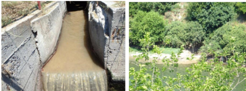
Slika 2. Obilazni kanal i ispuštanje sirovih otpadnih voda u rijeku Moraču, uzvodno od PPOV-a
