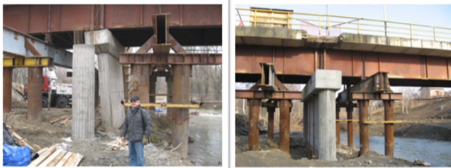
Слика 23: Мост на реци Пек, стуб С-3 раније фундиран на бунару, током санације срушен и фундиран на шиповима
