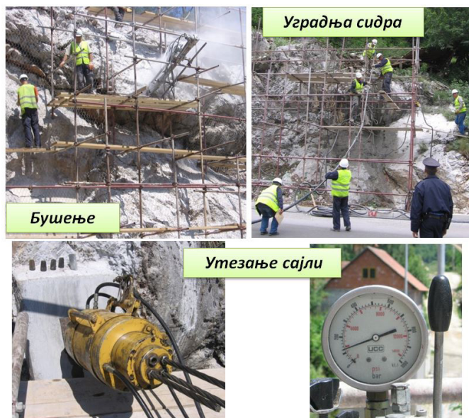
Слика 13: Бушење, уградња и утешање сајли сидра након инјектирања
