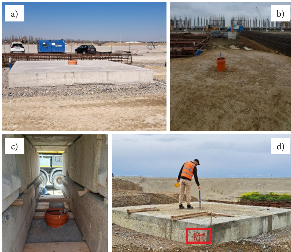
Slika 2: Izgled temelja izloženog statičkom opterećenju a) ZLT-3 s bušotinom u centralnom delu za osmatranje sleganja (pre izvođenja testa); b) bušotina u okolnom nasipu, pre izrade temelja u zoni ZLT-1; c) ZLT-1 u toku opterećenja s prostorom za fizički pristup bušotini; d) ZLT-2 nakon uklanjanja opterećenja, sa izgledom bušotine i geodetskim reperom R1
