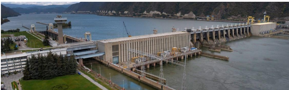
Slika 3. Hidroelektrana "HE Đerdap 1" [14]
