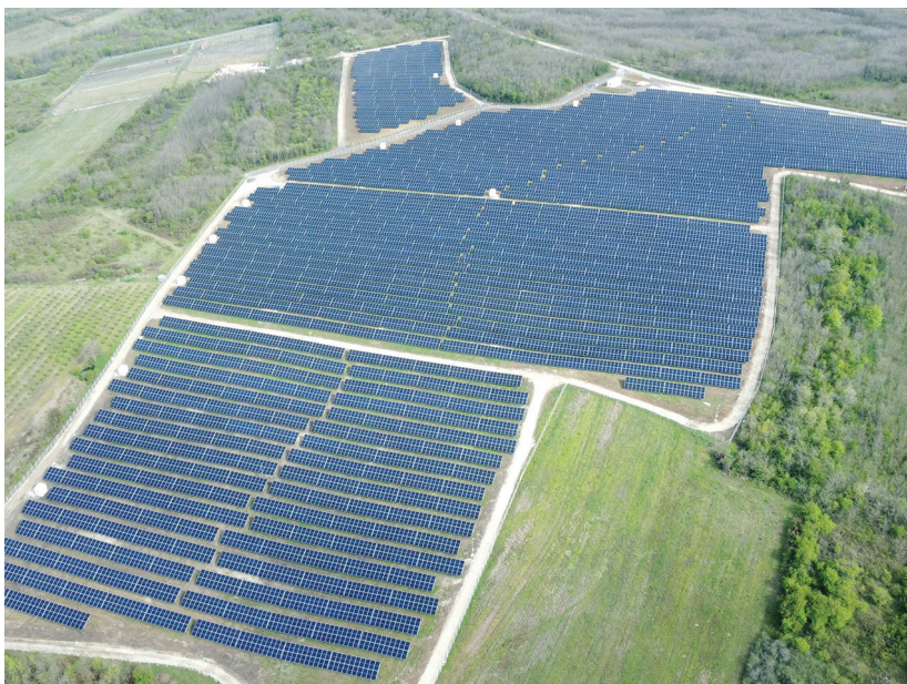
Slika 1. Solarna elektrana u Lapovu
